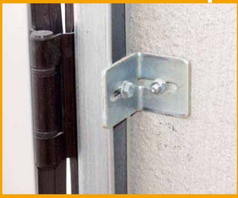
Staffa di fissaggio montante con asole per la registrazione.
