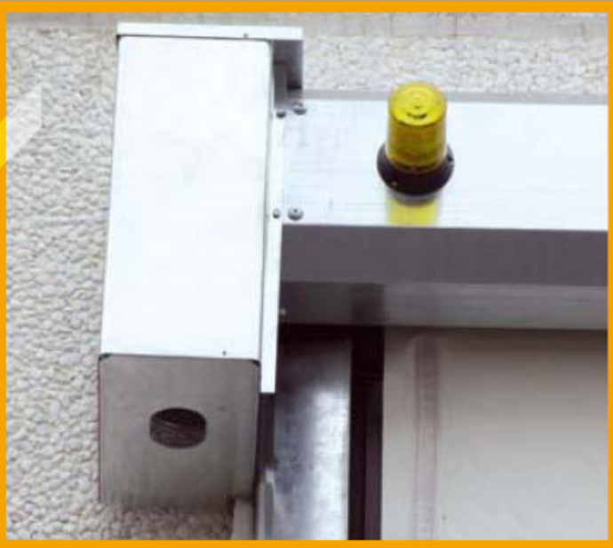
Carter di protezione motore
